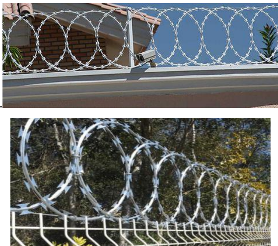
Imagem 13: Modelo de Aplicação da Concertina tipo plana.
